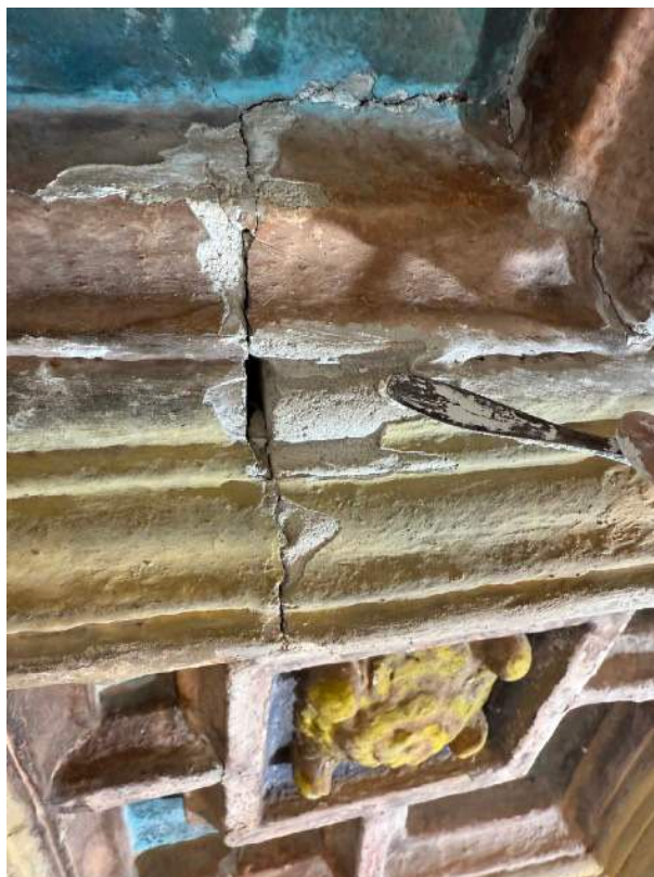
Detall durant la consolidació i reintegració de pèrdues amb estucs de tota la superfície.
