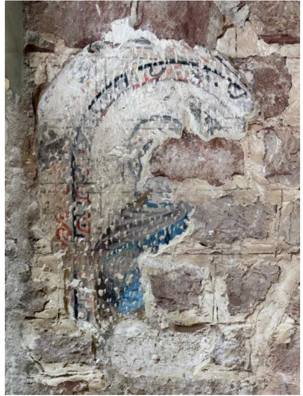
Imatge general de l'obra (després de la intervenció).
