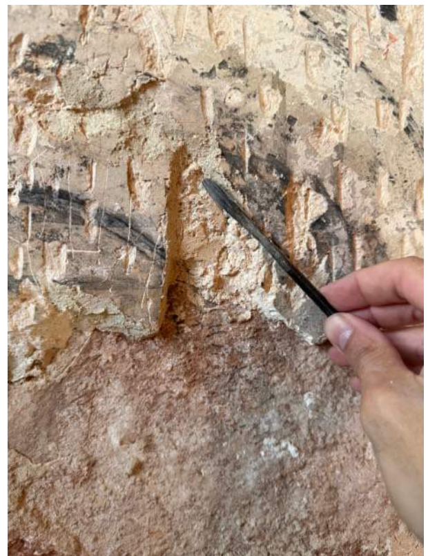
Imatge de detall durant el procés de bisellat amb morter de calç del perímetre de morter conservat.
