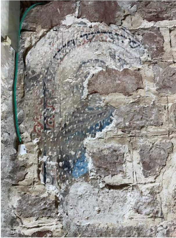
Imatge general de l'obra (abans de la intervenció).
