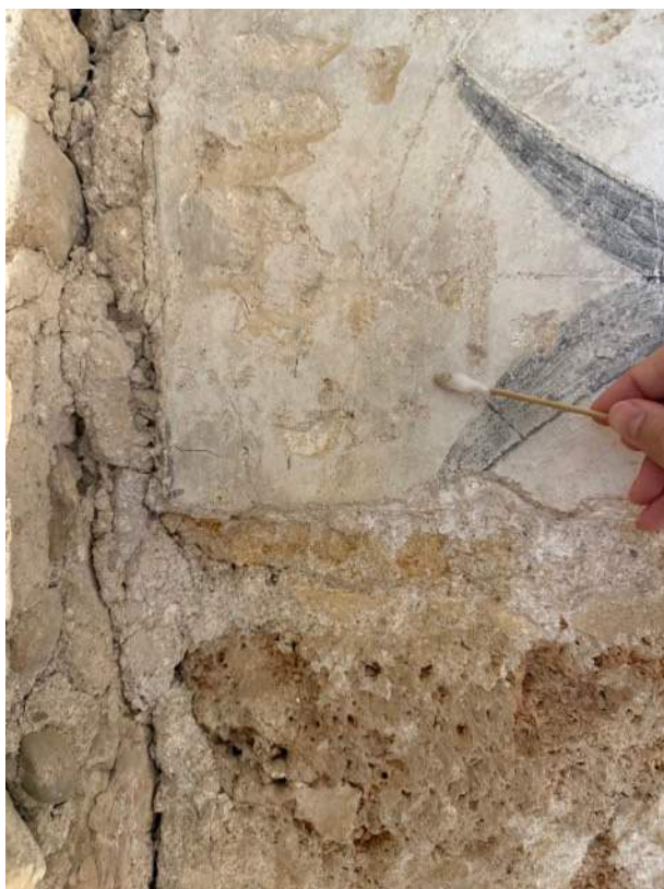
Imatge de detall durant el procés de neteja aquosa de la superfície de morter.
