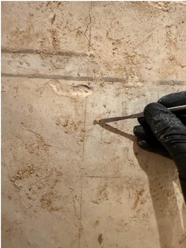
Imatge de detall durant el procés de neteja mecànica de la superfície de morter.
