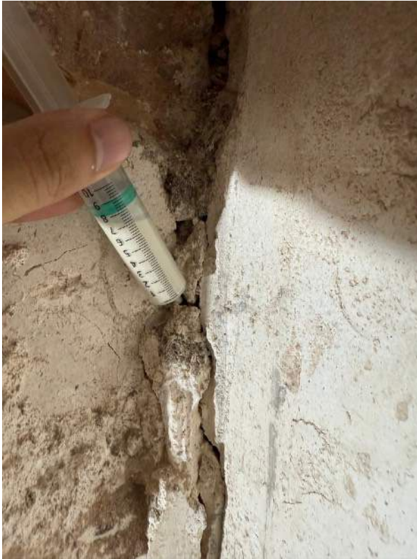
Imatge de detall durant el procés d'injecció de morters per a la consolidació de bosses d'aire.
