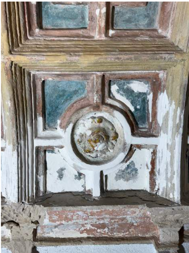
Detall d'un cassetó un cop efectuada la reintegració material de les pèrdues amb estucs.
