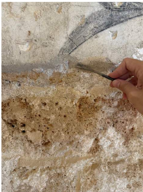
Imatge de detall durant el procés de bisellat amb morter de calç del perímetre de morter conservat.
