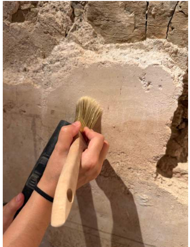
Imatge de detall durant el procés de neteja mecànica de la superfície de morter.
